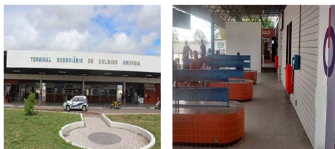
Figura 20 - Terminal rodoviário de Delmiro Gouveia.
