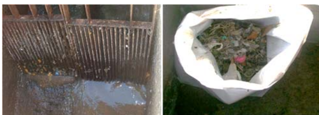
Figura 20 - Resíduos Sólidos interceptados na etapa de gradeamento do processo de tratamento de esgoto.
