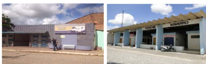
Figura 22 - Ilustração dos terminais rodoviários dos municípios de Flexeiras e Matriz de Camaragibe.
