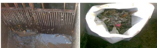
Figura 23 - Resíduos Sólidos interceptados na etapa de gradeamento do processo de tratamento de esgoto.
